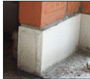
Aanzet binnenspouwblad op vloerplaat met Kimblok
