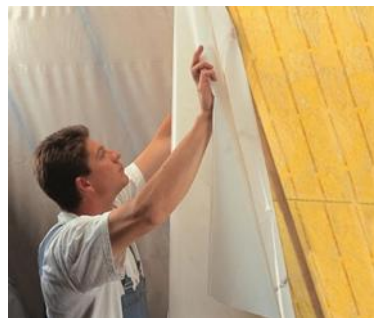
Aanbrengen van een dampscherm
