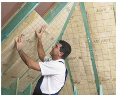
Plaatsing van dakisolatie met lambda-waarde 0,035 W/mK
