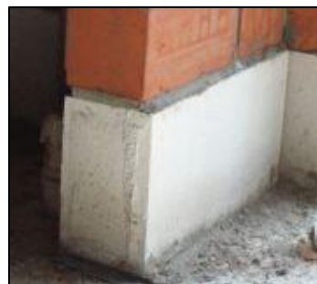
Aanzet binnenspouwblad op vloerplaat met Kimblok
